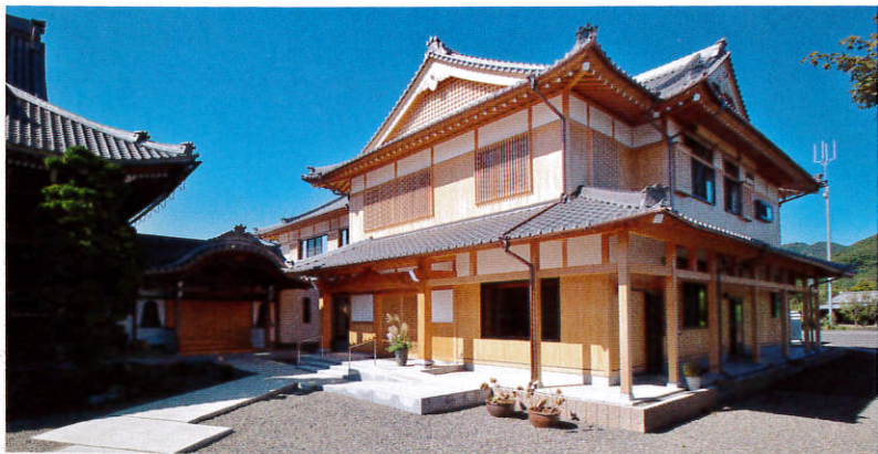
上/玄関右手の待合室。腰掛に囲炉裏を設置。上部は吹抜けで、2階リビングにつながっている。 中/玄関ホールには紙芝居舞台風の額縁とした床の間をつくった。季節ごとに絵を換えることができる。 ケヤキの大黒柱が印象的。 下/堂々とした大屋根の外観。美濃瓦の5寸勾配の反り屋根。それを支えているのは壮大な五重梁の小屋組。さらに40本を越える桔木を使っている。
