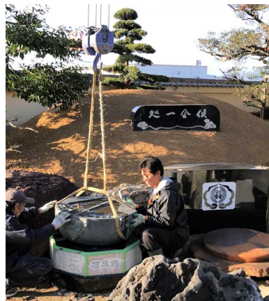
工事の最後に仏足石設置
