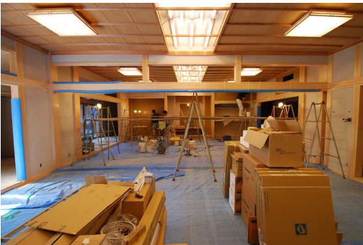
広間のメイン電灯40wが30本も使われていますがHf蛍光灯で節電だそうです。
