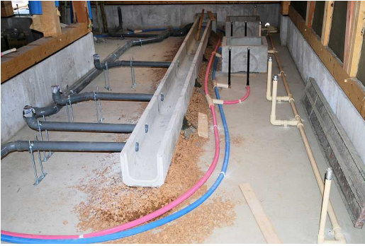
厨房土間部分の給排水は使い勝手を考え配置されました。
