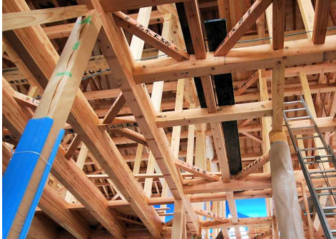
横揺れから柱を支える火打梁(ひうちばり)は264本取り付けられています。
