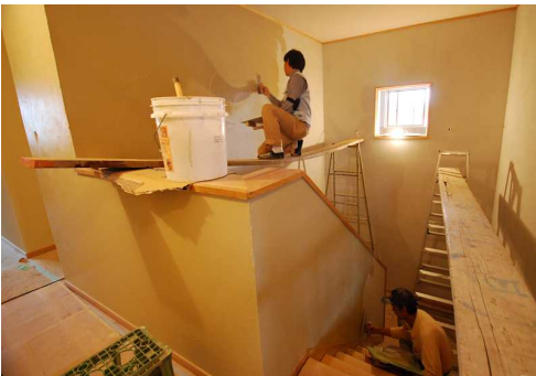
内部廊下は木造和風の雰囲気強調するため、珪藻土(はいそうど)の左官仕上げです。
