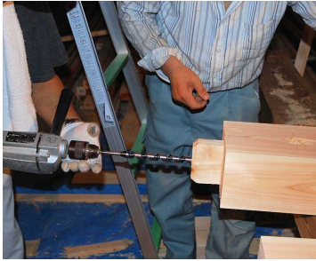
鴨居を固定する吊束(つりか)の中心に長い穴を開け、そこへ2階の床からボルトを通して固定します。
