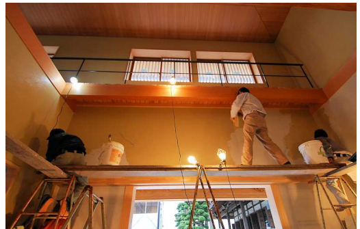
玄関吹き抜けは左官仕上げで壁とキャットウオークの対比がモダン風になりました。
