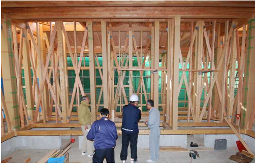
木造耐震を向上させるために壁は全てWの筋交(ずかい)が入っています
