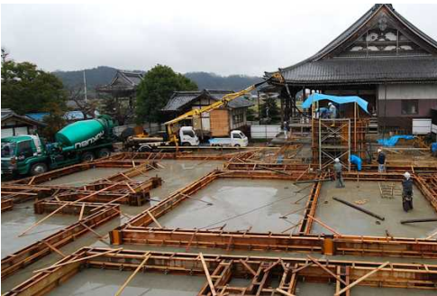
布基礎は5日間かけ木製型枠でガッチリ作られ、コンクリートが流し込まれました。
