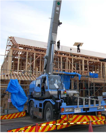
屋根の剛性を高めるため9ミリの合板を敷きます。
