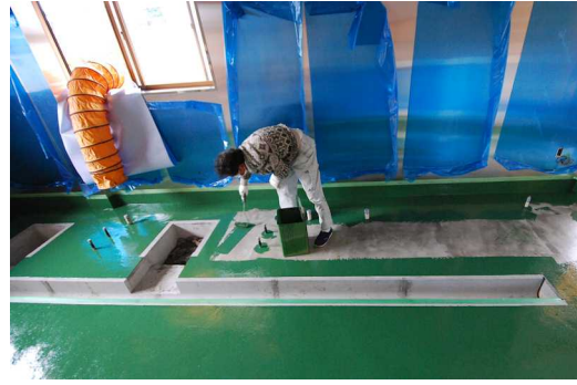
土間の表面は滑り止め骨材の入ったポリウレタン樹脂でお化粧してもらえました。
