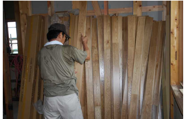
フローリングは縁板と相殺の材料変更でしたが、檜材の無垢板で貼ってもらえました。
