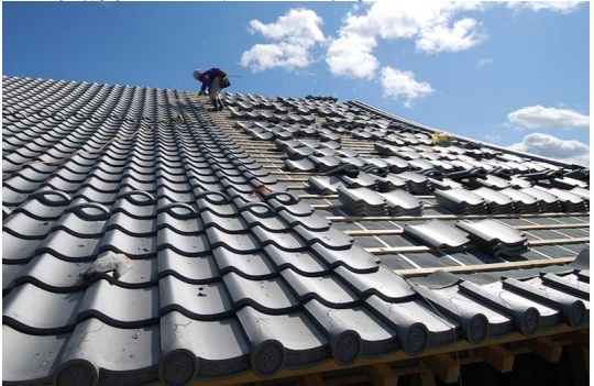
葺き始めから一月で大屋根部分の平瓦が葺きあがりました。
