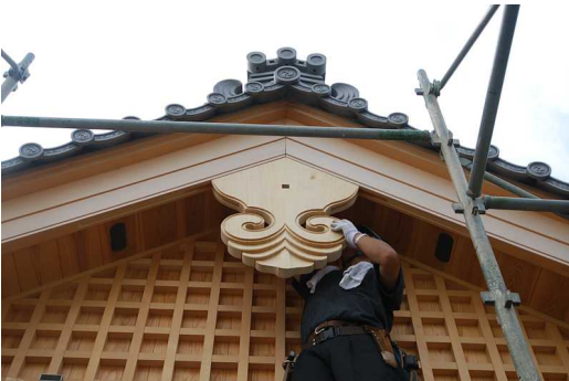
お彼岸の9月21日棟梁の手で大屋根三ヶ所の懸魚が取り付けられました。
