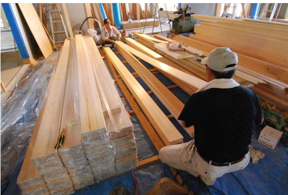
1階廊下は12cm巾から材料変更した18cm巾の桧無垢板が貼られました。
