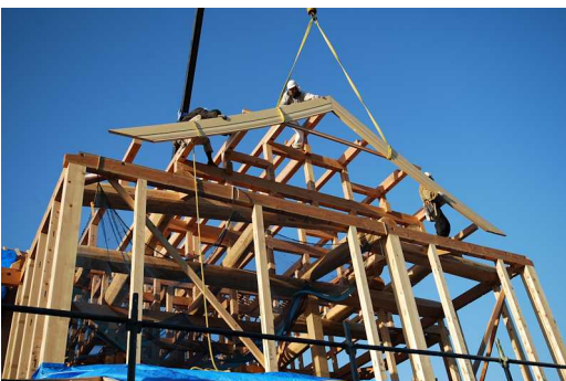
大屋根妻の破風が付けられ米杵葉の美しい曲線が現れました。
