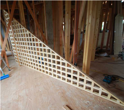
室内でお大工さんが米ヒバの角材を原寸に合わせて作ります。
