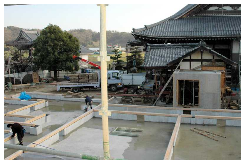
3月15日土台ができると大玄関も曳屋され、あるべきところへと落ち着きました。
