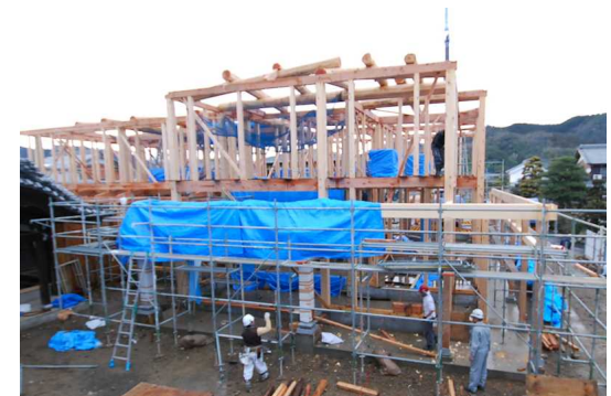
2階の地棟も据えられ1週間の作業が終わりました。
