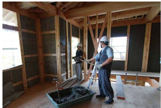
腐れドロという数年寝かせ発酵した緑色の土でヒビ割れしないそうです。
