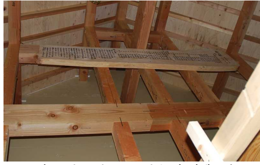
天井裏のまん中には耐火壁が造られ、その前に棟札が固定されています。
