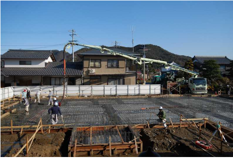
起工式から24日、ベタ基礎の鉄筋型枠も完成しコンクリート打ちが始まりました。
