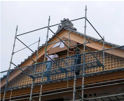
破風(はふ)に付ける懸魚(けぎょ)の大きさを原寸図で決めます。
