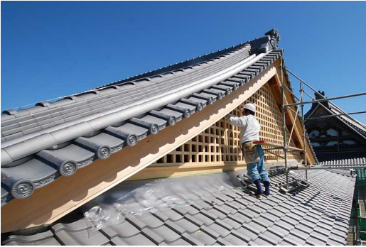
瓦が葺き上がった6月25日、大屋根妻の木連格子(きづれごし)が取り付けられました。
