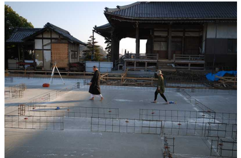
ベタ基礎には生コン車34台169㎡のコンクリートが使われました。
