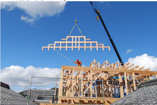
幅12尺5重の小屋組が2階の大屋根として運ばれ据え付けられていきます。
