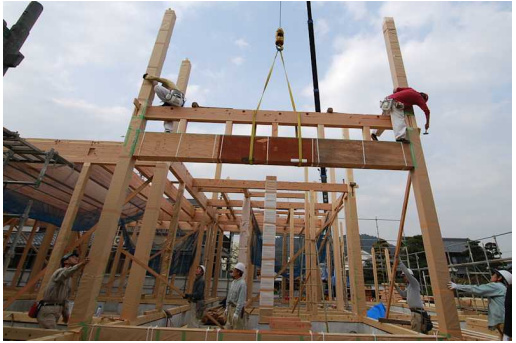
玄関上がり端の框(かまち)と鴨居(かまい)も建て起こされました。
