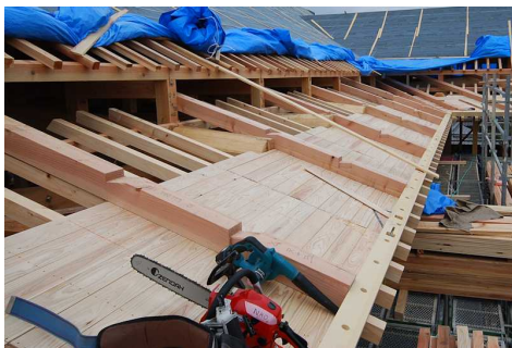
反った大屋根の先端は二重の垂木で作られます。
