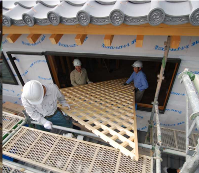
窓を開け屋根の上を破風妻はぶ封まで運んでいきます。
