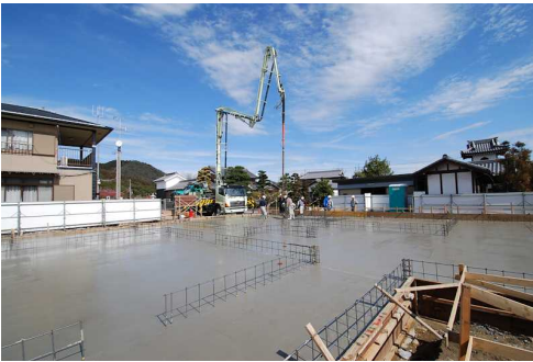
鉄筋の鳥籠は広いコンクリートフロアに変わりました。あれだけあった鉄筋が布基礎分僅かとなりました。
