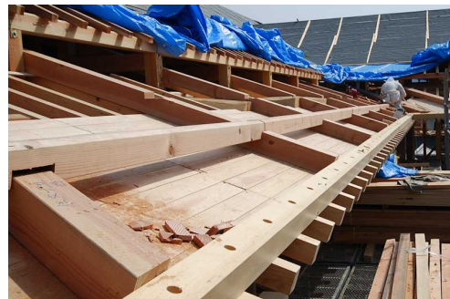
テコの原理を使ったハネ木工法で屋根の先端を持ち上げます。
