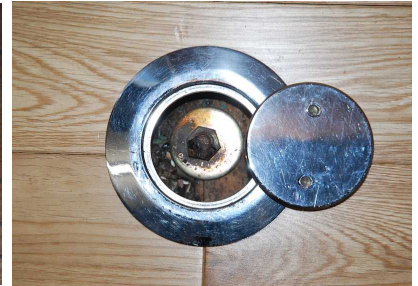
2階座敷の下と納戸に吊束調整ボルトヘッド隠れています。
