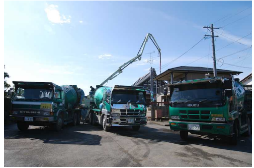
ベタ基礎には生コン車34台169㎡のコンクリートが使われました。
