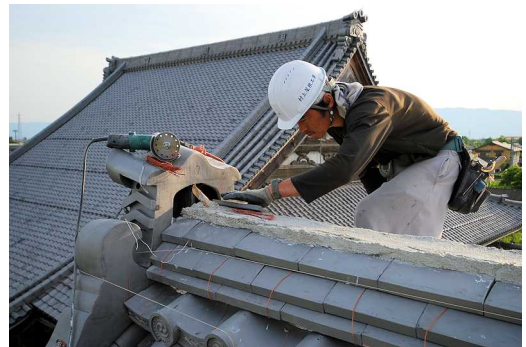
高さ11mの天辺に絶妙な角度で鬼瓦が据えられます。
