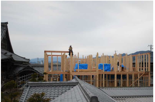
4日目、2階部分の柱が大量に立てられていきました。
