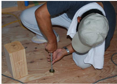
鴨居を固定する吊束(つりか)の中心に長い穴を開け、そこへ2階の床からボルトを通して固定します。
