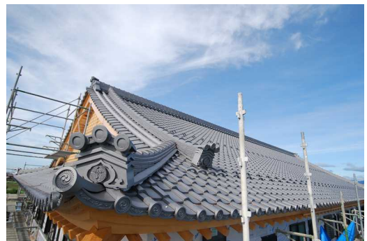
6月30日2ヶ月半を要し美しい姿の瓦屋根が完成しました。
