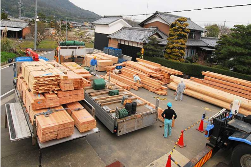
朝から何台ものトラックで材木が大量に運び込まれ駐車場は貯木場でした。
