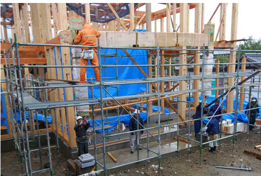
向拝造りの玄関は慎重にクレーンを操作しながら基礎石ぴったりと納まりました。
