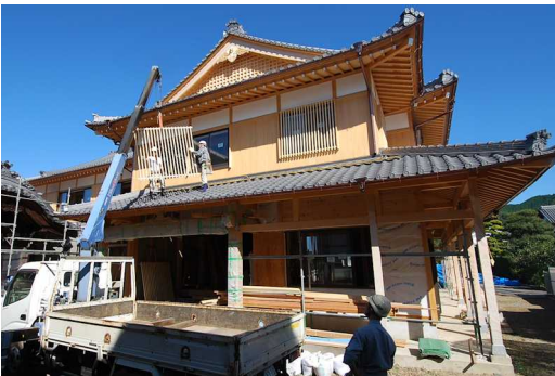
建て方から8ヶ月、足場が撤去され玄関吹き抜けに格子が取付られました。
