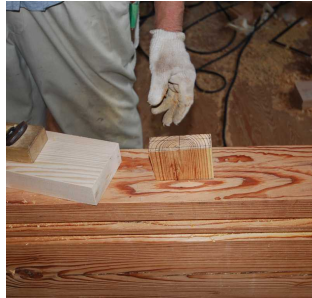
ホゾ穴を木口で埋め旧庫裏の面影を残しています。
