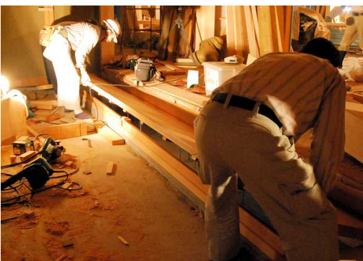
幅60cm長さ6m厚さ5cmケヤキ無垢板の上がり框(かまち)踏板が取り付けられました。
