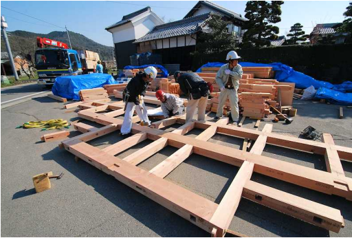
建て方8日目、大屋根の下地を作る作業が始まりました。
